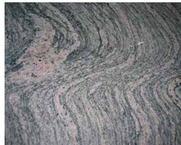
Figuur 3. Plooiën zichtbaar in natuurstenen wandbekleding uit een pand aan de Oude Gracht in Utrecht.
